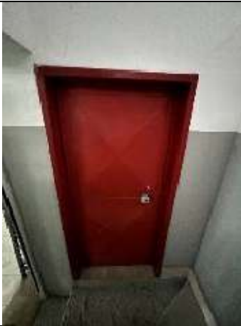
Foto n. 33 – Deposito piano interrato – Accesso vano ascensore e montacarichi
