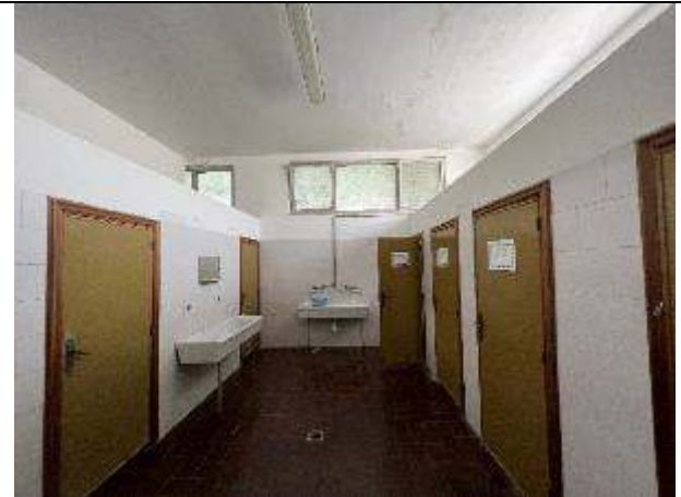
Foto n. 56 – Capannone P.T. - Bagni
