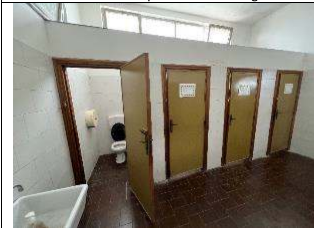
Foto n. 57 – Capannone P.T. - Bagni
