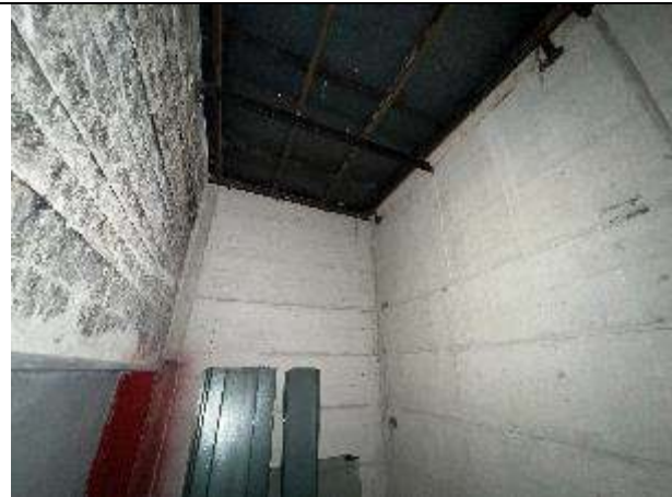
Foto n. 36 – Deposito piano interrato – Interno vano ascensore e montacarichi
