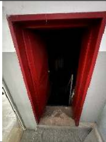
Foto n. 34 – Deposito piano interrato – Accesso vano ascensore e montacarichi
