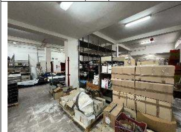
Foto n. 21 – Deposito piano interrato
