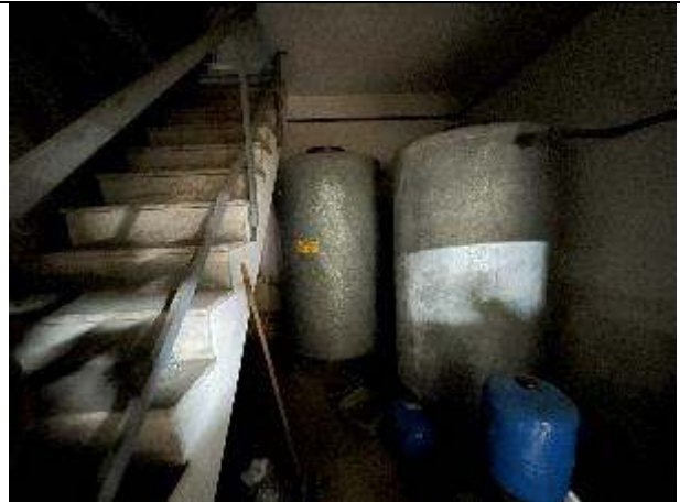
Foto n. 26 – Deposito piano interrato
