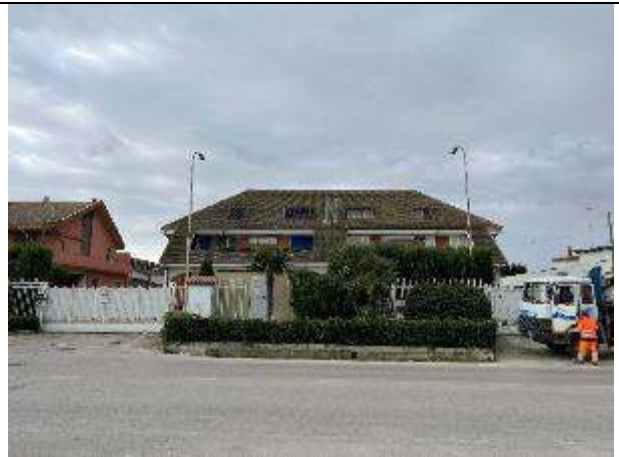
Foto n. 2 – Vista ingresso via Trani
