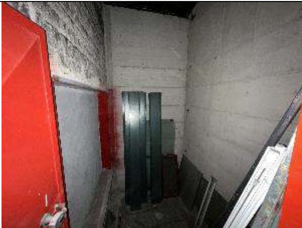
Foto n. 35 – Deposito piano interrato – Interno vano ascensore e montacarichi
