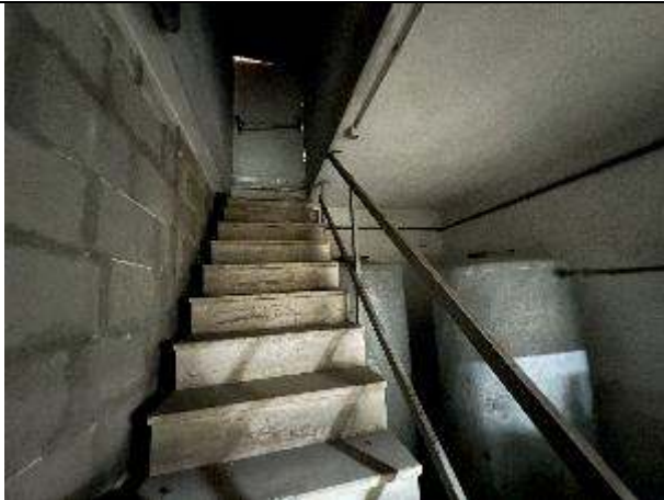
Foto n. 25 – Deposito piano interrato
