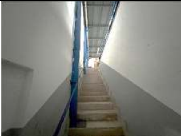
Foto n. 37 – Scale accesso dal piano terra al Deposito piano interrato
