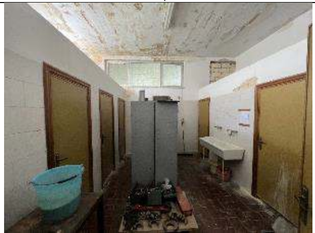
Foto n. 54 – Capannone P.T. - Bagni
