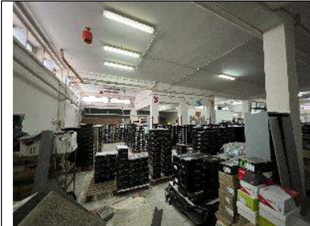
Foto n. 19 – Deposito piano interrato
