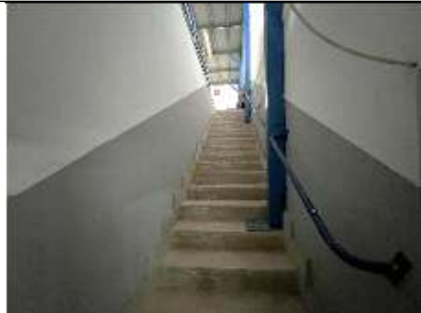
Foto n. 38 – Scale accesso dal piano terra al Deposito piano interrato
