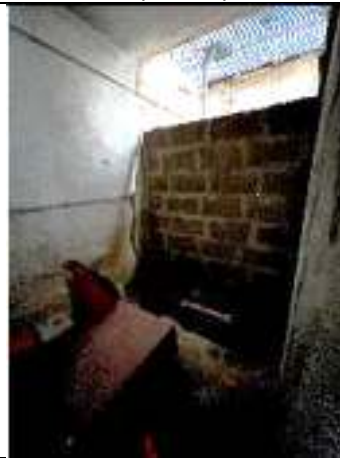
Foto n. 28 – Deposito piano interrato
