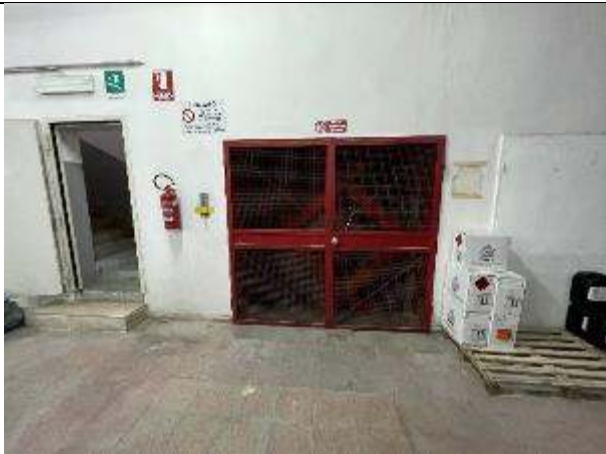
Foto n. 29 – Deposito piano interrato - montacarichi
